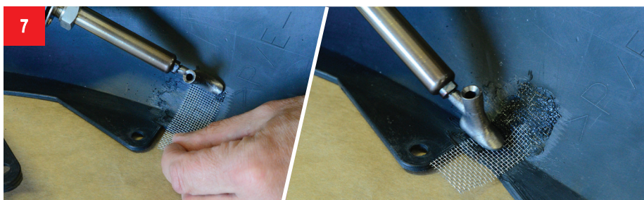
7 С помощью устройства точно запаиваем сетку в материал по внутренней стороне повреждения.
