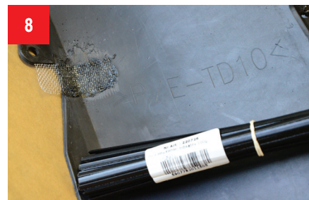
8 Чтобы скрыть алюминиевую сетку и укрепить ремонтируемый участок, выбираем для ремонтируемой пластмассы соответствующее
