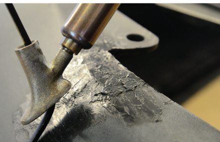
14 ...и загибаем наружу, запаивая его в пластмассе с помощью инструмента.
