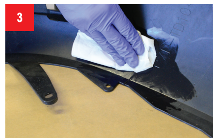
3 Очистка и обезжиривание места ремонта с помощью WK900 с обеих сторон повреждения.
