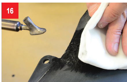
16 В случае слишком быстрого плавления связующего вещества охлаждаем ремонтируемое место с помощью салфетки, смоченной в холодной воде.
